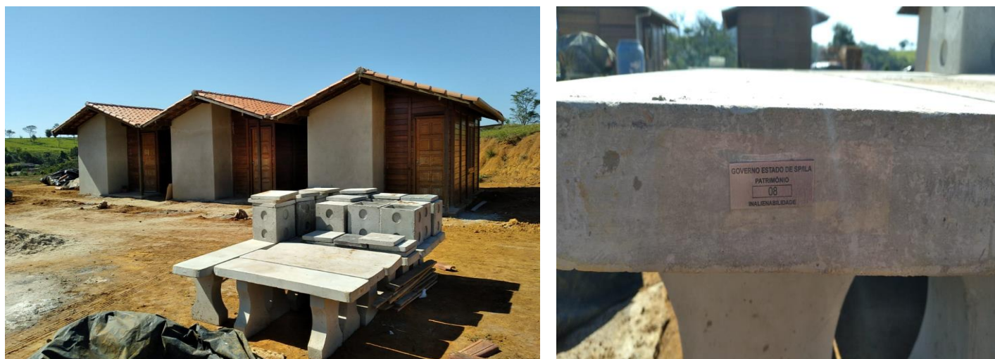
Figura 8: Bancos de concreto - Banco de concreto 8
