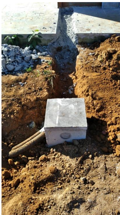
Figura 2: Caixas de elétrica instaladas
