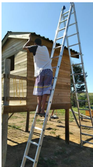
Figura 30: Escada Extensiva : embora a escada extensiva tenha sido alocada na sede atual, conforme descrito no Plano de Trabalho, foi encaminhada para a nova sede devido ser necessária para vários usos na obra.
