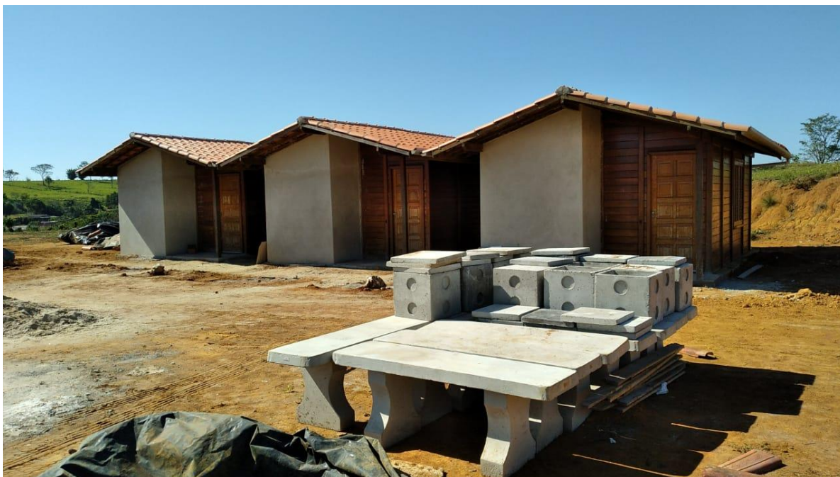
Figura 31: Bancos de cimento
