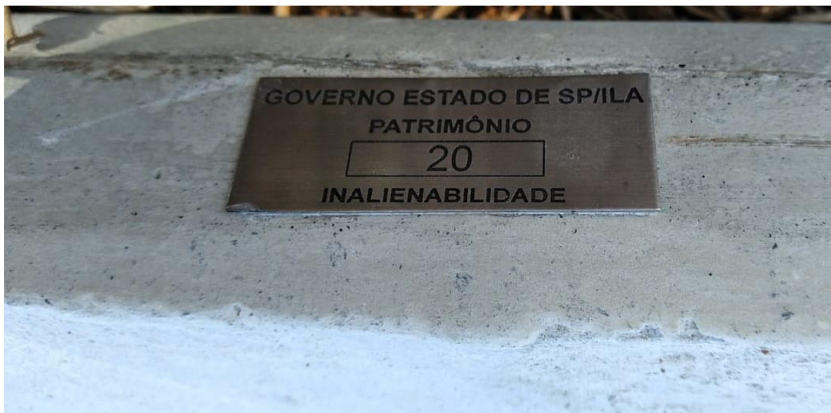
Figura 20: conjunto de mesas e bancos de concretos desmontados
