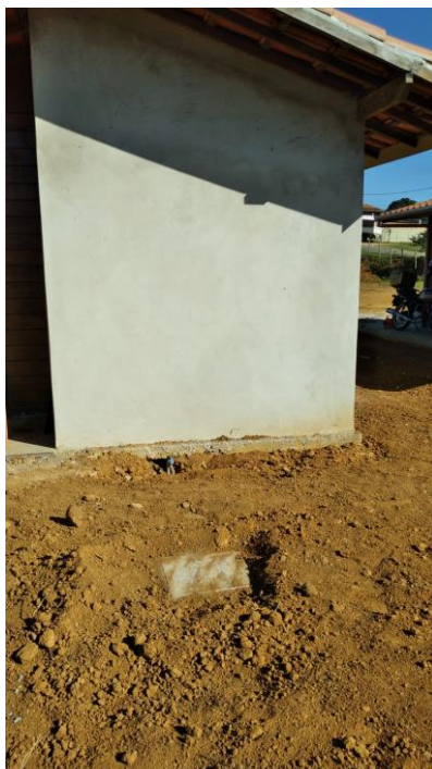
Figura 3: Caixas de água instaladas
