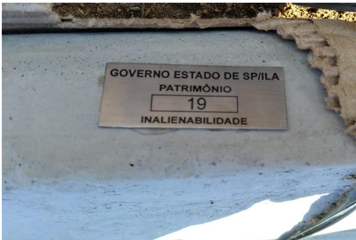
Figura 19: conjunto de mesas e bancos de concretos desmontados
