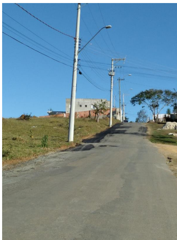
Figura 66: Reparos na pavimentação na principal avenida do bairro.
