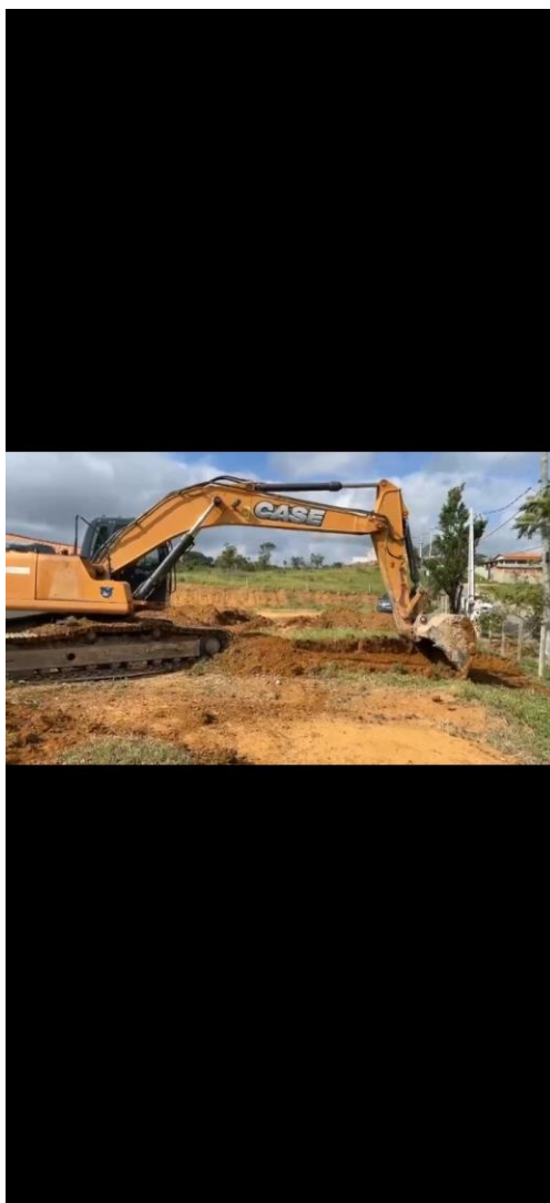
Figura 47: Máquina de terraplanagem delimitando e nivelando o acesso ao Parque Inclusivo e à Horta Comunitária.
